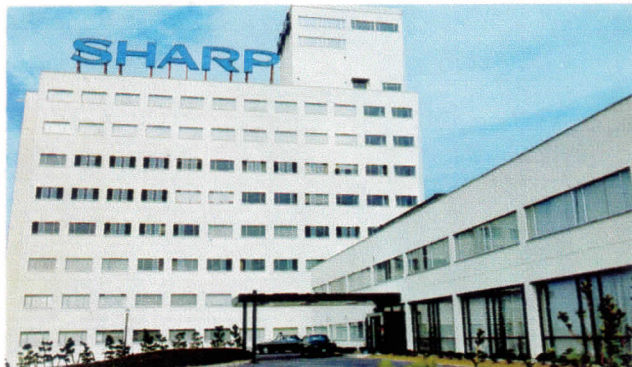
新しい技術を次々と創出するシャープ総合開発センター(天理市)
